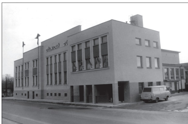
172 / Dělnický dům po rekonstrukci 1985.
