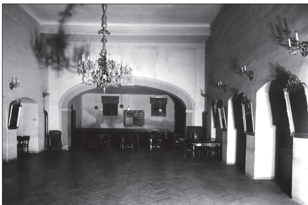
301 / Sál domu čp. 126 U zlatého orla. Od roku 1798 se zde hrálo divadlo na jevišti ochotnického spolku.
