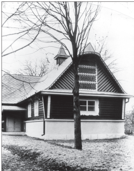
375 / Budova Loutkového divadla Sokola otevřená 1928.
