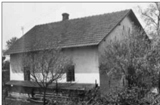
Dům čp. 38 – budova MNV postavená v roce 1928.
