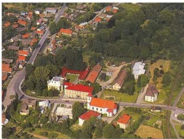
Obr. 2 – Letecký snímek obce Branky.
