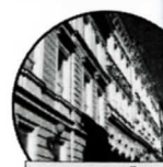
Budovy ZUŠ a ZŠ ve Školní ul.
