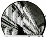
Budovy ZUŠ a ZŠ ve Školní ul.
