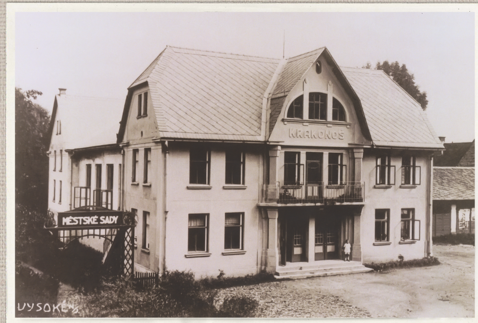
Budova divadla roku 1930. Povšimněte si eternitové střechy a dnes již opět obnovené brány městských sadů.
