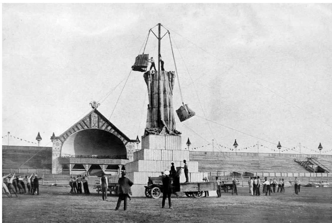
Obr. 4 Zkouška stavby sochy
