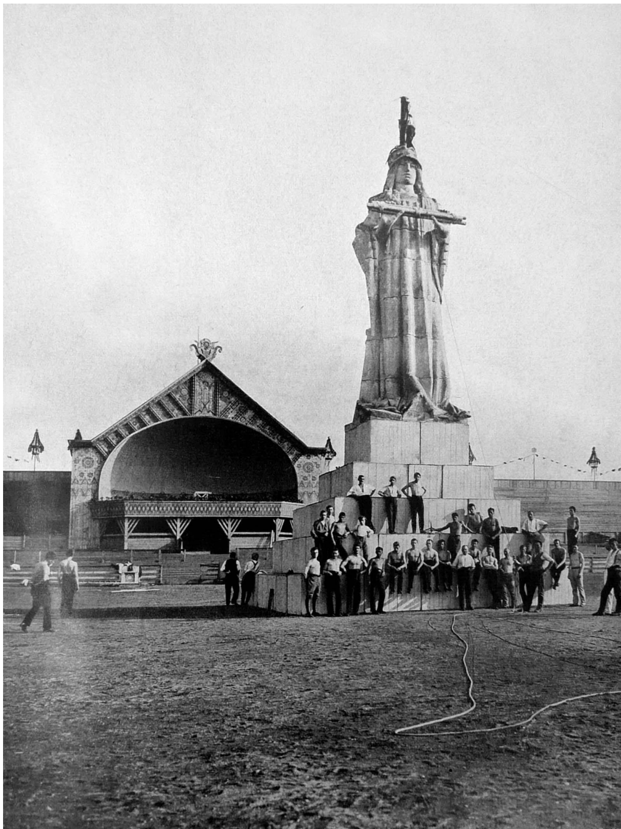
Obr. 5 Dokončení stavby na zkoušce
