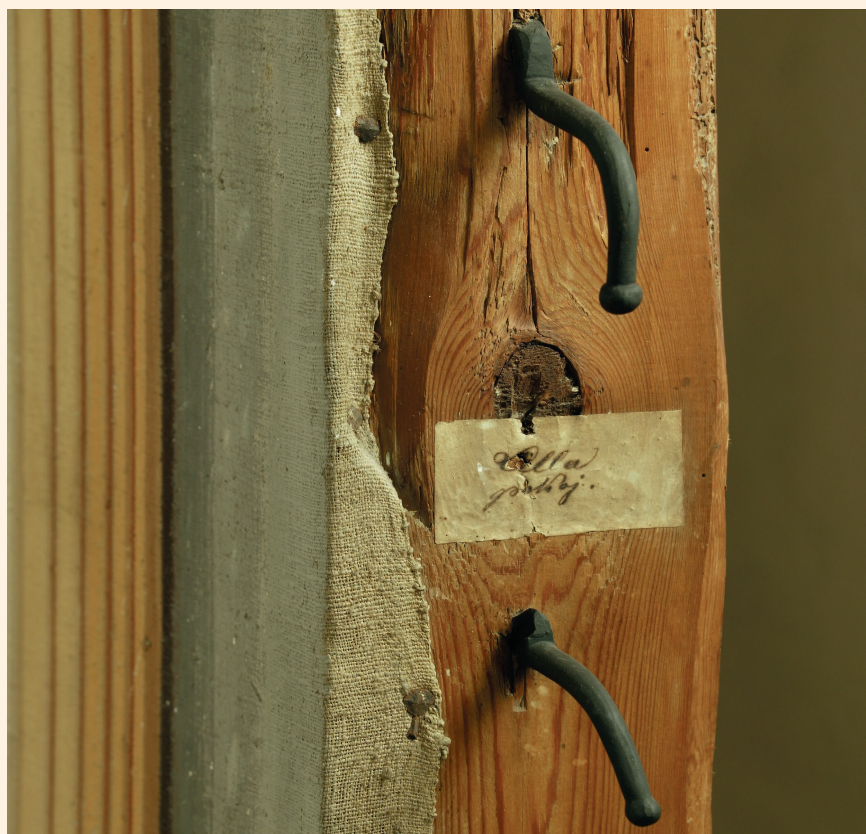
DETAIL HÁKŮ NA UCHYCENÍ LAN OD PROSPEKTŮ, ZAJÍMAVOSTÍ JSOU ČESKÉ NÁZVY JEDNOTLIVÝCH SCÉNIKÝCH OBRAZŮ.
