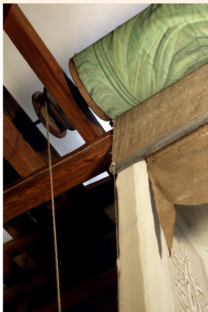
DETAIL UMÍSTĚNÍ VÁLCE S PLÁTNEM OPONY V PROVAZIŠTI A CÍVKA S NAVINUTÝM LANEM PRO OVLÁDÁNÍ (STAV PO RESTAUROVÁNÍ).
