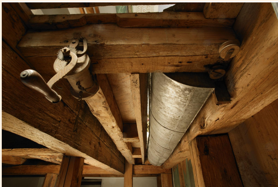
POHLED Z PODJEVIŠTNÍHO PROSTORU NA PLECHOVÉ STÍNIDLO RAMPOVÉHO OSVĚTLENÍ, KTERÉ SE OVLÁDALO POMOCÍ KLIKY. OVLÁDACÍ
