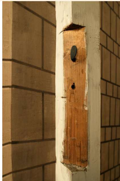
ZÁŘEZ A SKOBA PRO ZAVĚŠENÍ LAMPY NA OSVĚTLOVACÍ LATI MEZI BOČNÍMI KULISAMI.
