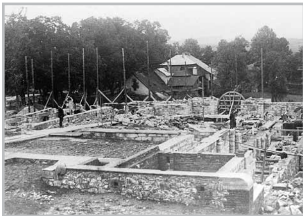
Postup stavby divadla na dobových fotografiích – základy
