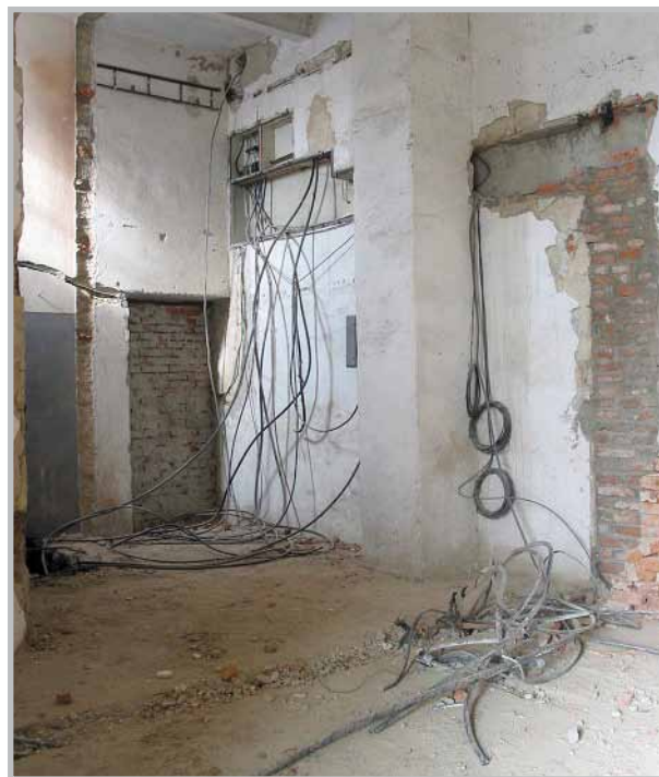
Příprava na výměnu rozvodů
