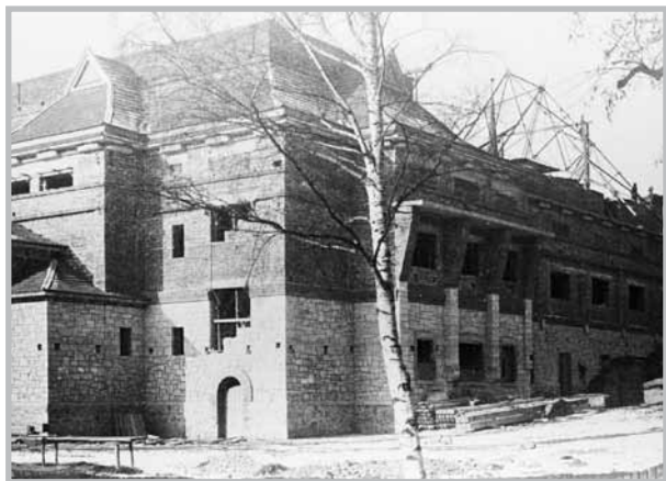
Výstavba divadla – hrubá stavba
