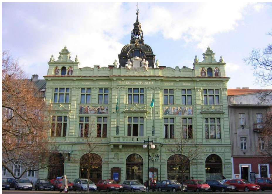
Budova Městské besedy
