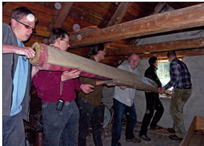
...a již se oknem stěhující ven na plošinu přistaveného valníku
