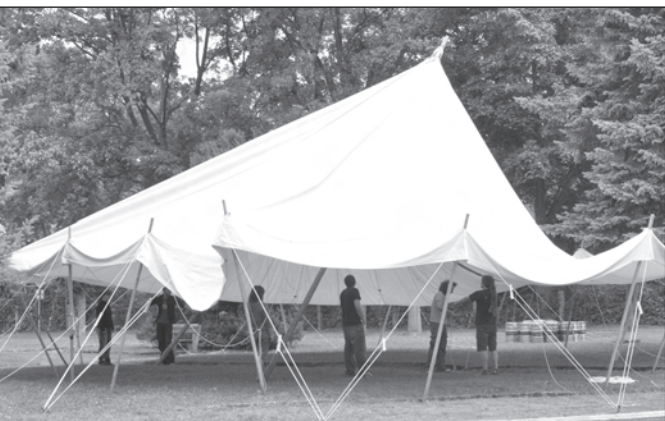
Stavba stanu o parku u Tritonu. Foto: Ivo Mičkař
