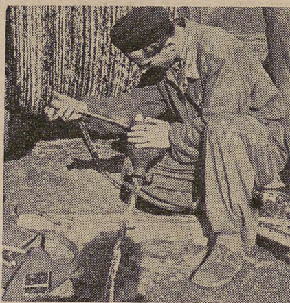
Záběr z elektroinstalace na letní scéně
