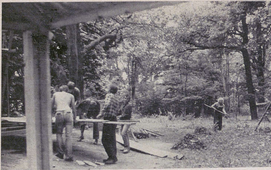
Takhle se začalo budovat otáčivé hlediště divadelního souboru Vltavan v Týně nad Vltavou
